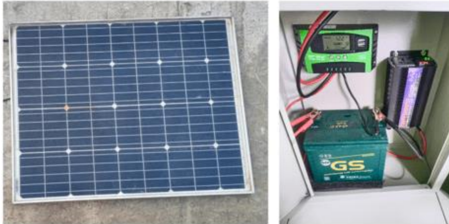
Gambar 5. Komponen Pembangkit Listrik Tenaga Surya
